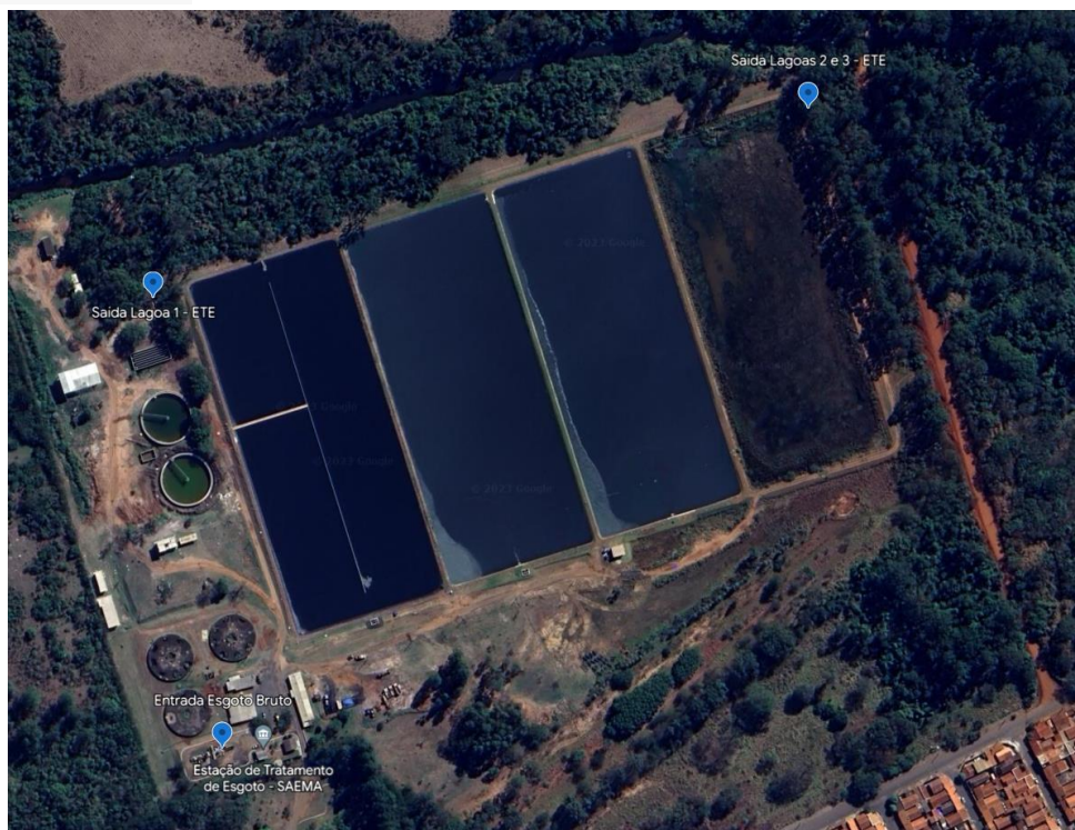
Localização dos pontos 02, 03 e 04 do Lote 02 – Fonte: Imagem Google Earth
